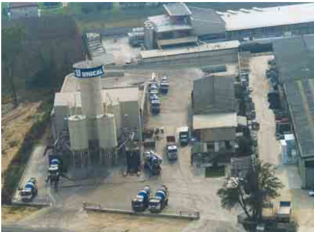
Santena (Torino): nuovo impianto di betonaggio Santena (Torino): the new ready-mix concrete batching plant
