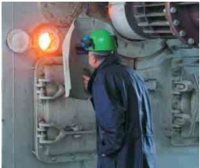
Stabilimento di Barletta (Bari): controllo della fiamma del bruciatore Barletta plant (Bari): checking the burner flame
